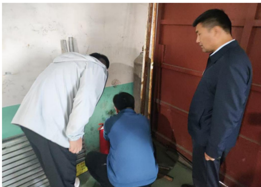
图 28：消防安全巡查
