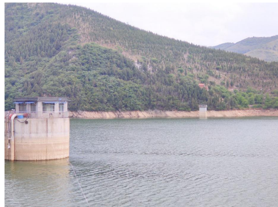
图 2 响泉-龙洞泉水源地取水井
