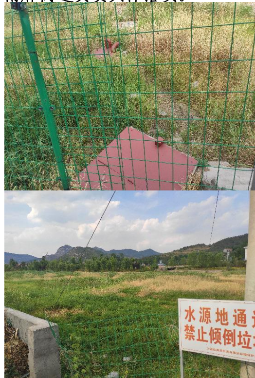
图 2 钓鱼台水源地现有隔离防护措施
