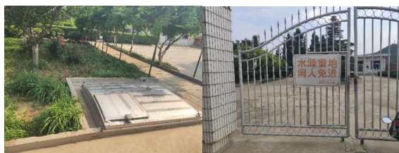
图 2 芝芳水源地现有隔离防护措施
