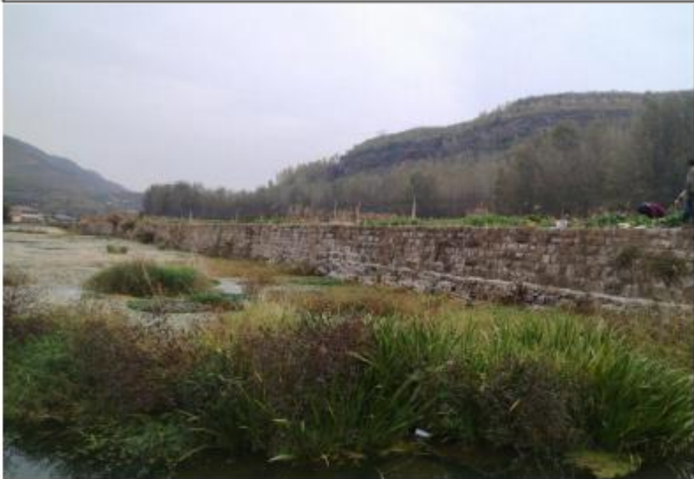
河道 30+420 现状照片
