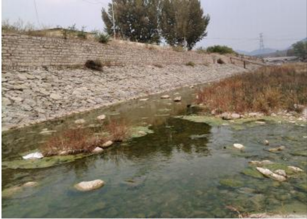
河道30+420 现状照片
