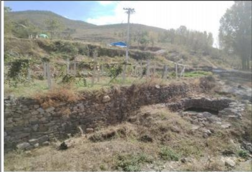
河道上游现状照片
