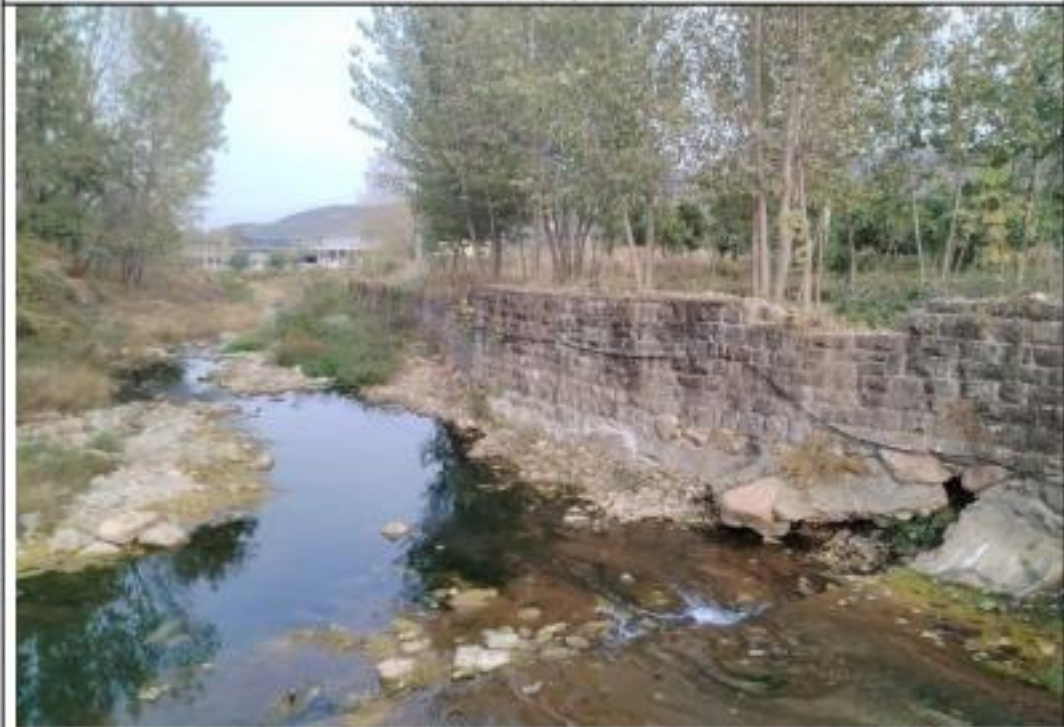
河道 35+470 现状照片
