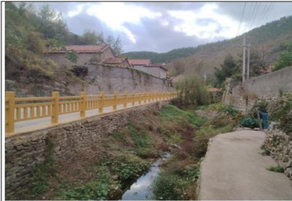
河道 41+310 现状照片
