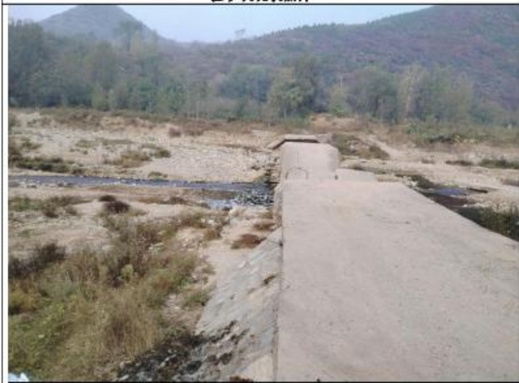
桩号 32+884 拟建桩基桥处现状照片
