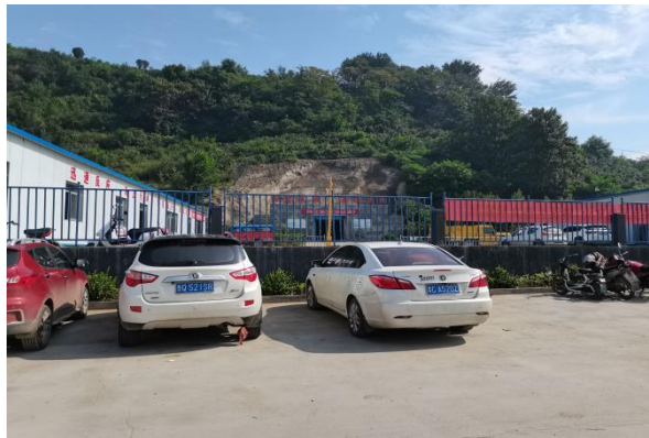
上河辅助斜坡道
