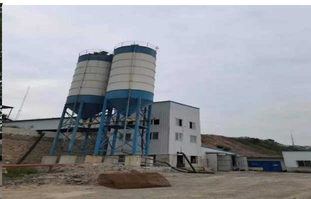
尾矿库充填站
