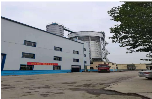
主副井场地-充填站
